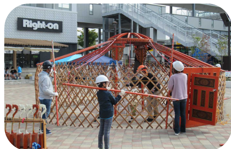
屋根の部分にとりかかります
